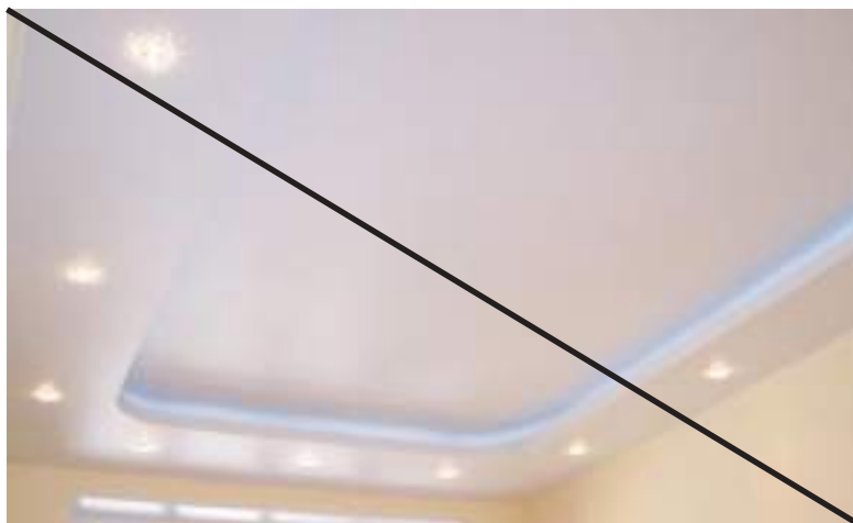
Плохо Многоуровневые гипсокартонные конструкции
